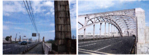
十三大橋 昭和7年完成。全長681m
